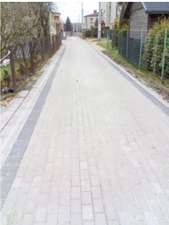
przebudowa „odnogi” ul. Gliwickiej w Pilchowicach
