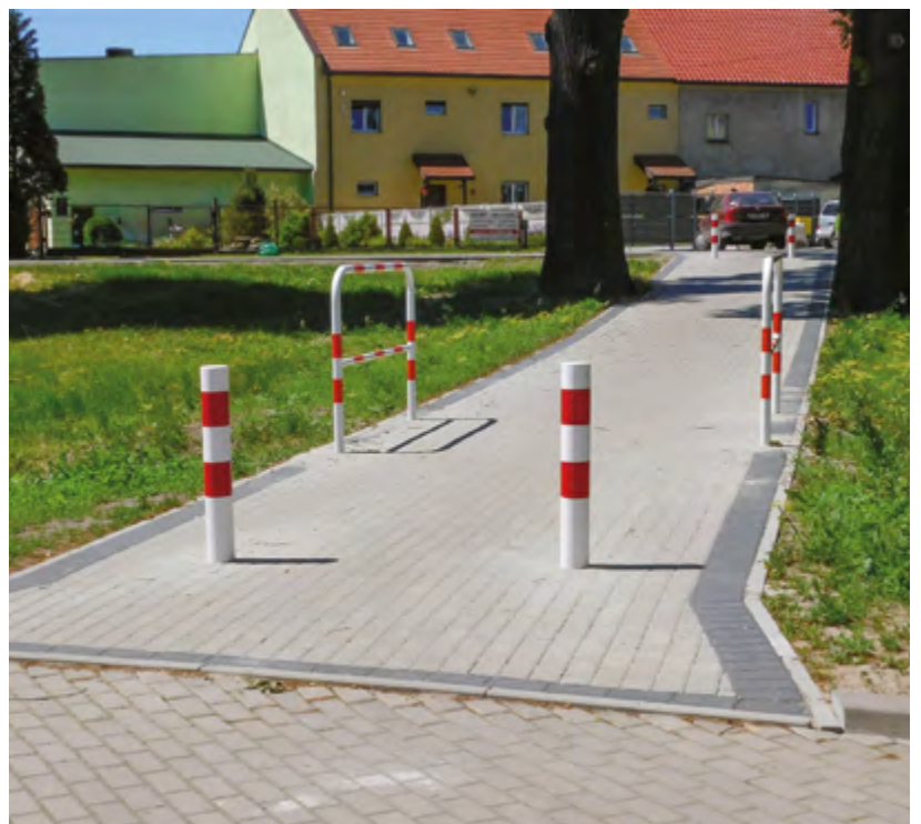
utwardzenie ścieżki obok Urzędu Gminy
