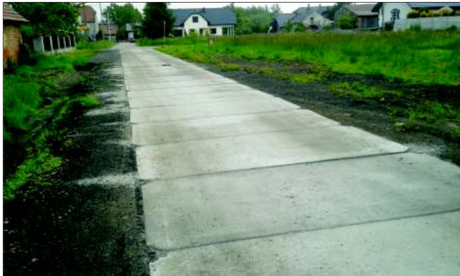
I po remoncie.
