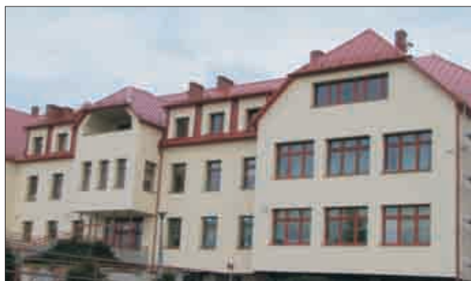
Nowy dach szkoły w Żernicy
