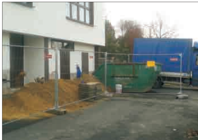
Termomodernizacja przedszkola w Pilchowicach
