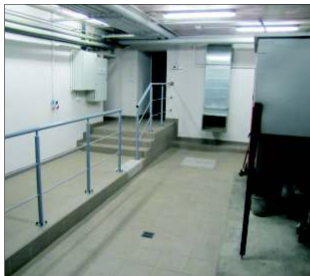
Pomieszczenie kotłowni po remoncie.
