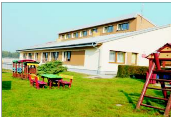
Nieborowickie przedszkole - termomodernizacja
